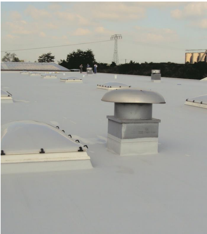
Foto 3.4. (Flachdach mit Dachdurchdringungen)
